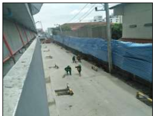
ภาพที่ 13 ทางวิ่งคอนกรีตสำหรับใช้เป็นเส้นทางวิ่งของรถบรรทุกวัสดุก่อสร้างในพื้นที่โครงการ
