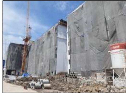
ภาพที่ 19 ผ้าใบกันฝุ่น (Mesh Sheet)
