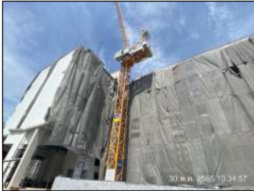
ภาพที่ 19 ผ้าใบกันฝุ่น (Mesh Sheet)
