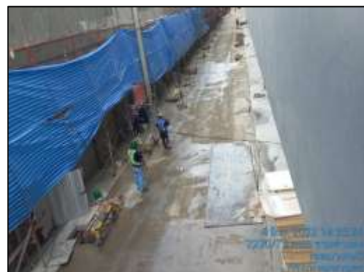
ภาพที่ 13 ทางวิ่งคอนกรีตสำหรับใช้เป็นเส้นทางวิ่งของรถบรรทุกวัสดุก่อสร้างในพื้นที่โครงการ
