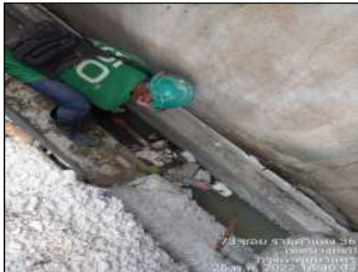
ภาพที่ 33 ทำความสะอาดรางระบายน้ำ
